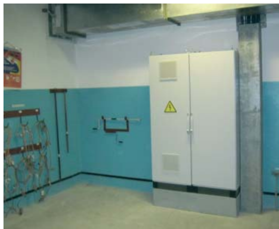
Рис. 5. Расположение ПТК TREI-5B-05 на ГПП3
