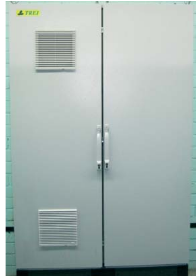
Рис. 3. Внешний вид шкафа КП на базе ПТК TREI-5B-05 на РП94
